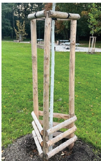
Ilustr. obr. kotvení a ochranných příček
